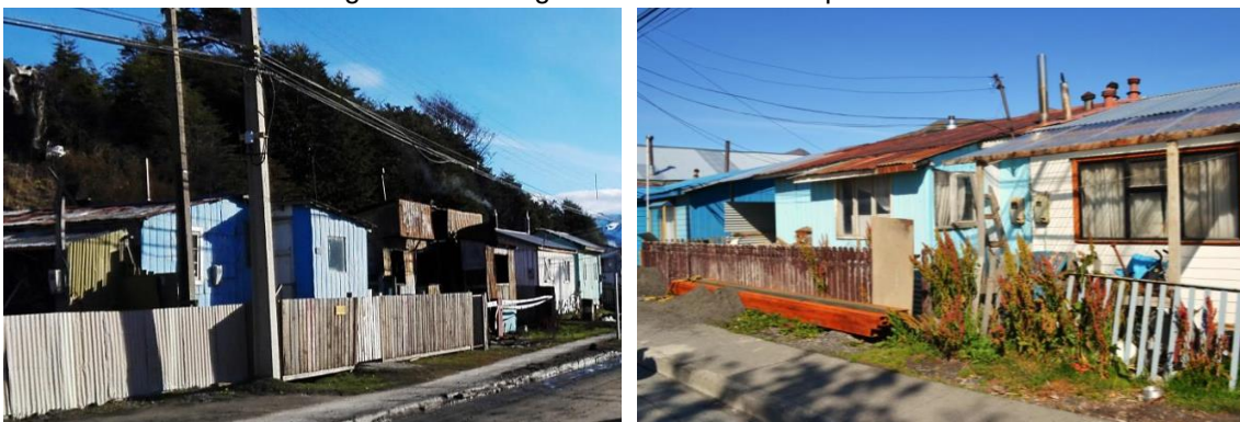
Figura II-36: Imágenes construcción espontánea
