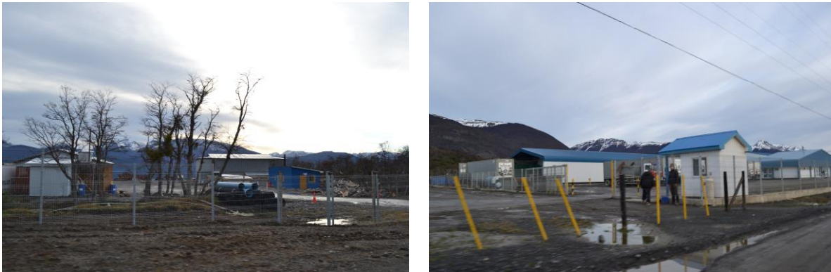
Sector oriente barrio industrial
