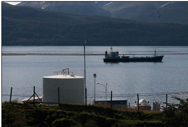
Fotografía 21: Infraestructura Energética, Puerto Williams
