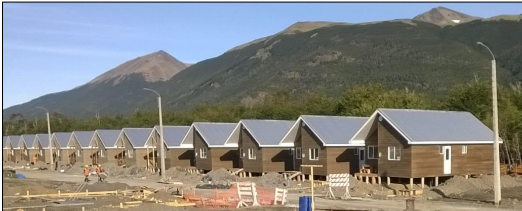
Fotografía 5. Inmuebles construidos sobre palafitos muy delgados, susceptibles a derrumbe ante un sismo muy fuerte.
