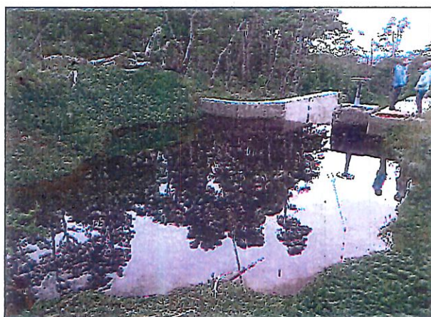
Imágenes captación de hormigón y estanque de acumulación agua cruda.
