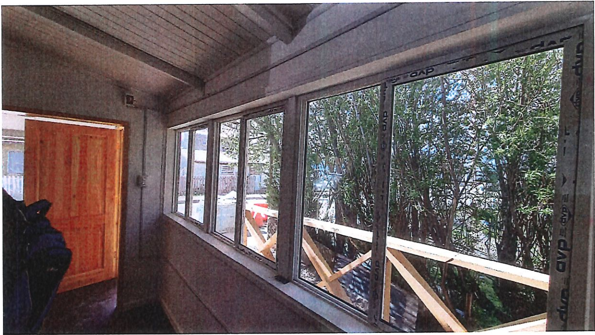
2.- Dormitorios, con su revestimiento de volcánita, pintura, piso flotante y ventanas termopanel.
